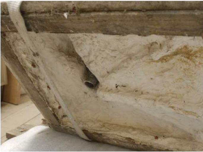
Photo 21 - les jambes sont renforcées par des tubes en acier récupérés
